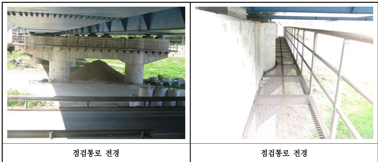
【사진 1.3.25】 교량 점검시설 전경
