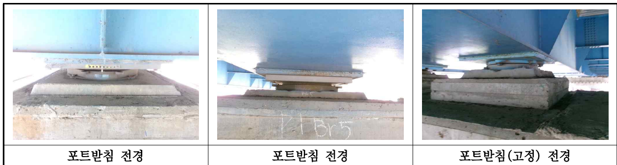
【사진 1.3.12】 교량받침 전경
