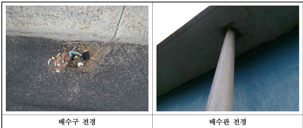
【사진 1.3.21】 배수시설 전경
