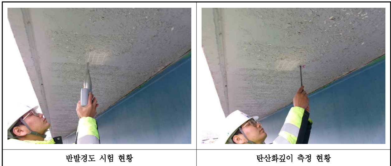
【사진 1.4.1】 콘크리트 내구성조사 현황
