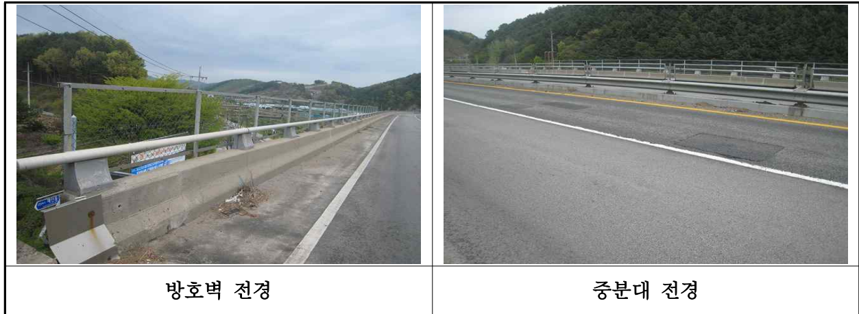
【사진 1.3.23】 방호벽 및 중앙분리대 전경
