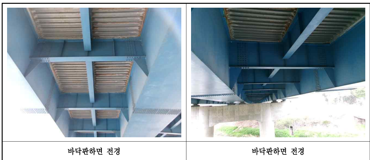
【사진 1.3.2】 바닥판하면 전경
